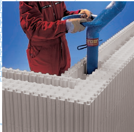
Anschließend werden die isorast-Steine maschinell mit Transport- oder Silobeton verfüllt.
